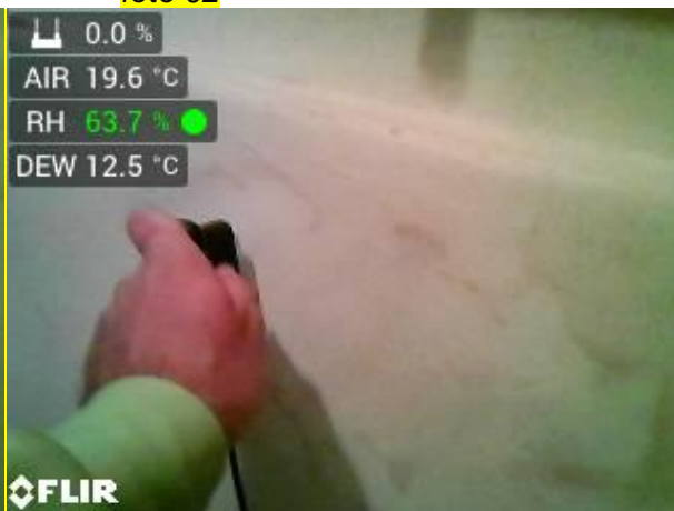
foto 04 0.01 schodiště vlhkost 0 % hm
