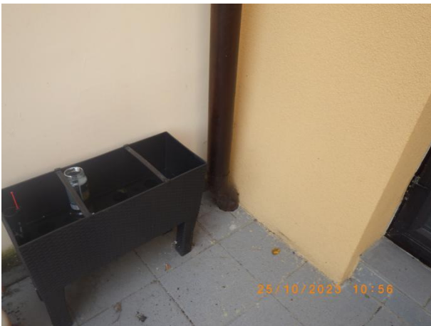
foto 56 schází lapač střešních splavenin
