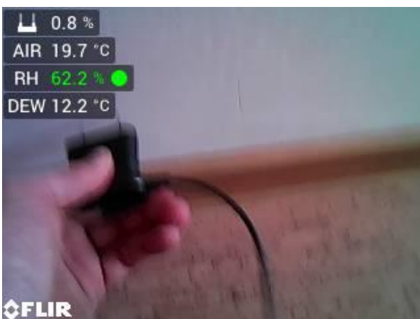
foto 25 1.01 chodba 1 vlhkost 0,8 % hm
