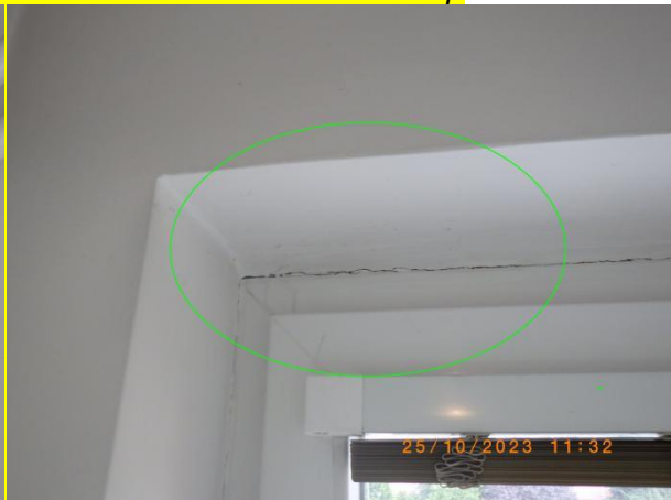
foto 54 2.06 chodba poškozená styčná spára
