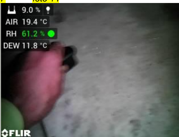
foto 16 0.02 garáž podlaha vlhkost 9 % hm
