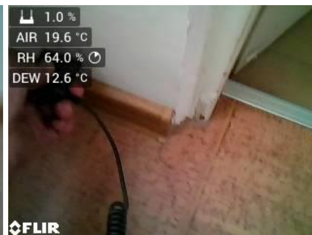
foto 26 1.01 chodba 1 vlhkost 1 % hm
